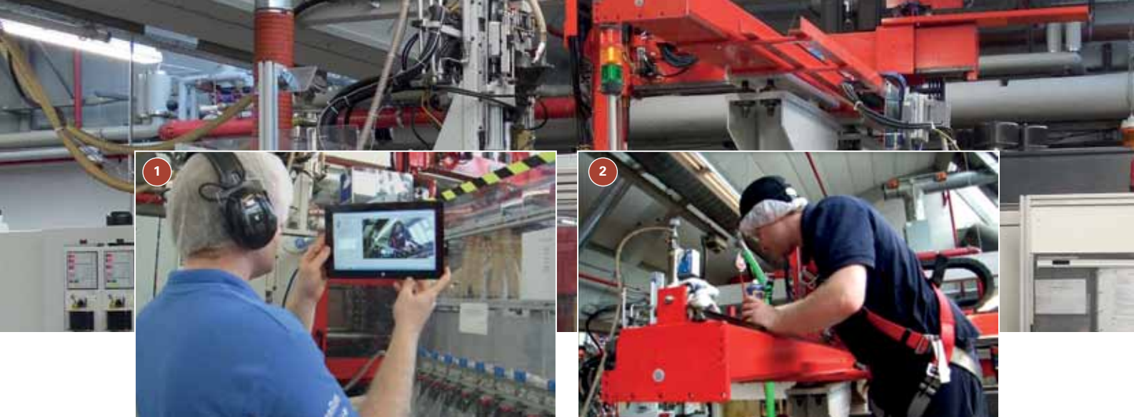
(10-1) Service-Techniker mit Tablet vor der Anlage (10-2) Service-Techniker bei Wartungs- und Instandhaltungsaufgaben
